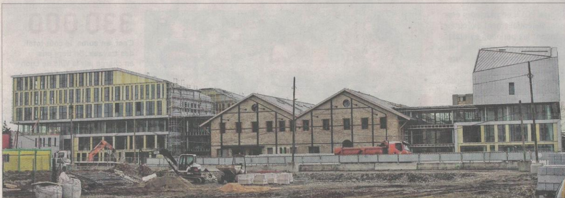
■ Au 75, rue de Gerland, le Septen accueillera le centre de recherche d'EDF, sur 20 000 m 2 , ainsi que des bureaux et 21 000 m 2 de logements. Photo Alexandre VIEIRA
