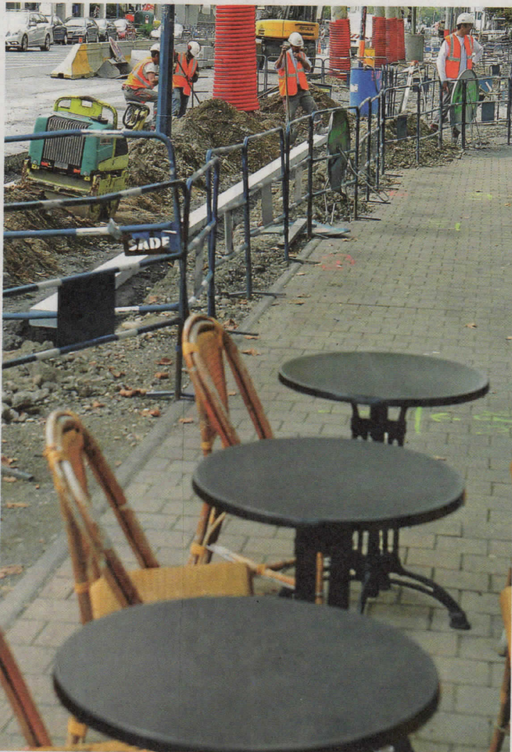
Les travaux de prolongement de la ligne de tram perturbent l'avenue Debourg.
